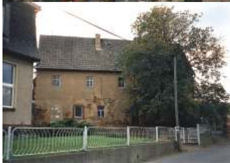
Die 1817 wiedererbaute alte Kirchsche zwischen neuer Schule und Kirche kurz vor deren Abriß 1994
