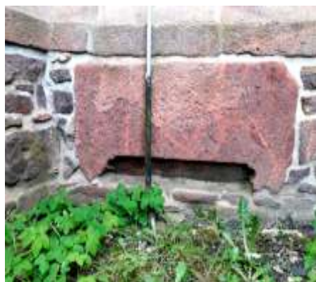
Beim Choranbau 1514 wurde in der Grundmauer der Nordwand u.a. ein Öffnungssturz aus dem Abriss der alten Turmwand wieder mit verbaut
