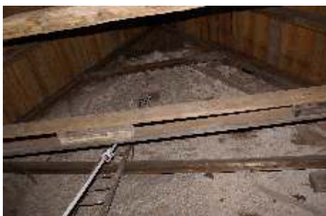
Der früher flachere romanische Dachverlauf des Kirchenschiffes ist an Ost- und Westgiebel noch gut zu erkennen. Spätere Umbauten erfolgten nach dem neueren spätgotischen Baustil etwas steiler. Viele originale Balken aus der Entstehungszeit des Kirchenschiffes sind noch im Dachstuhl erhalten, sowie auch im Turmdachstuhl.
