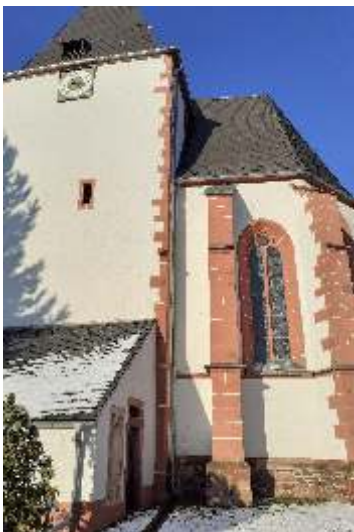
Der auch von aussen gut erkennbare unsymmetrische Anbau der Stützfeiler links und rechts des Turmes
