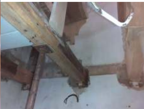
Die stark verrotteten Balkenstümpfe an der Nord- (rechts) und Südempore (links) wurden 2023 entfernt sowie neue "angeschuhrt". Dabei entdeckte Herr Körner an der Nordempore auch das weiter vorn bereits erwähnte und abgebildete Tischlerbrett von Theodor Frommherz von 1861.
