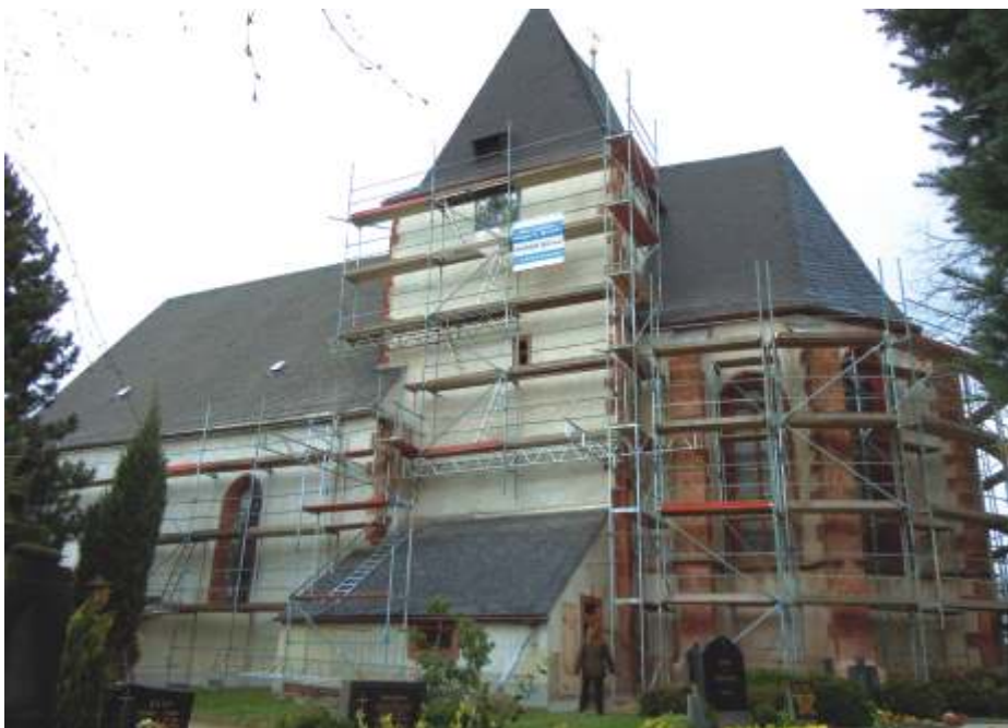
Moderne Baugerüste bieten Sicherheit und sehr gute Arbeitsbedingungen
