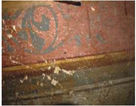
Am Aufgang zum Turm hinter der Orgel ist noch die alte Farbgestaltung der Kirchenwände von 1881 zu sehen
